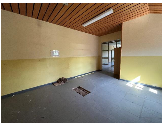
Foto 5: DG: Flur, Bauteilöffnung Boden, Aufschluss Bodenaufbau
