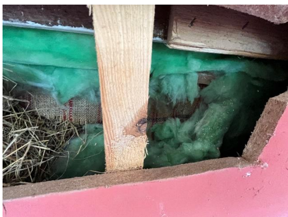
Foto 11: 1. OG: KMF zwischen Leichtbauwand
