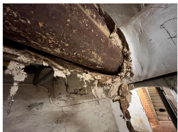
Foto 18: KG, alte poröse Rohrummantelung
