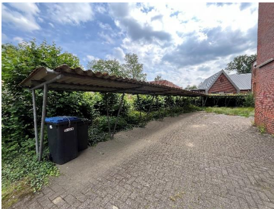
Foto 3: Unterstand aus Asbestzement-Platten
