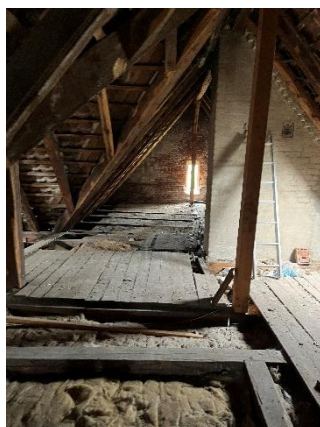
Foto 9: Spitzboden, KMF zwischen Deckenbalken
