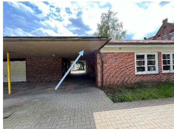
Foto 4: Durchgang, Dachüberstand wird abgebrochen
