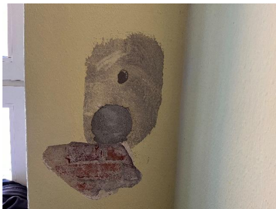
Foto 15: EG, Kernbohrung durch AG, Aufschluss Wandaufbau
